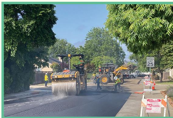
街道修复工程需采用复杂的道路重建技术来恢复路面。目前，市府正实施该计划的第四阶段工程，最后一阶段（第五阶段）预计将于2026年施工。
